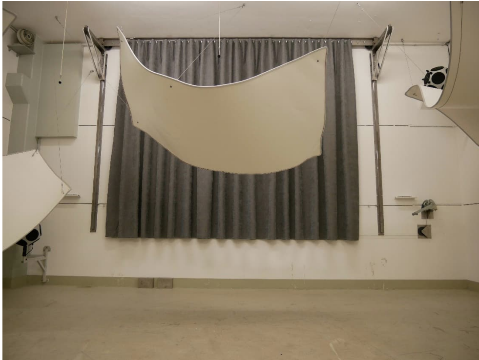
Abbildung B.1. Prüfanordnung im Hallraum (frontale Ansicht).
